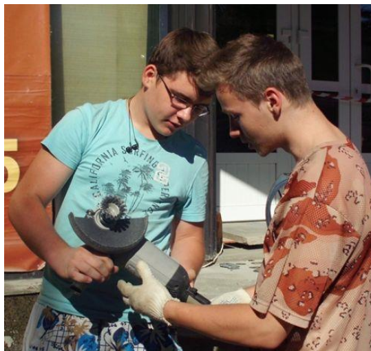
Первокурсники Евгений Бикеев и Давид Козлов на ремонте главного входа учебного корпуса
